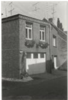
Driezenstraat / heraanleg (Foto 07030-01)
