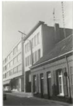
Driezenstraat / heraanleg (Foto 07030-02)
