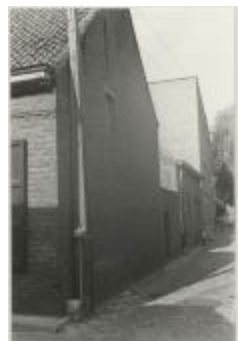
Driezenstraat / heraanleg (Foto 07030-10)
