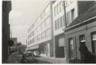
Driezenstraat / heraanleg (Foto 07029-06)
