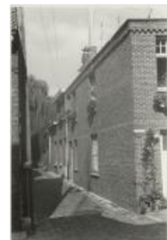
Driezenstraat / heraanleg (Foto 07030-12)
