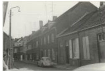
Driezenstraat / heraanleg (Foto 07029-03)
