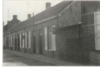
Driezenstraat / heraanleg (Foto 07029-11)
