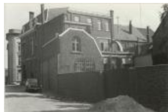
Driezenstraat / heraanleg (Foto 07030-07)
