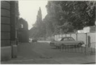
Driezenstraat / heraanleg (Foto 07029-09)
