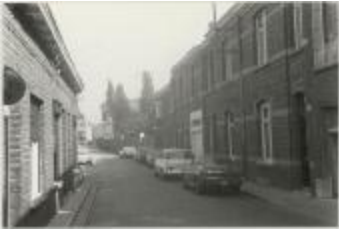
Driezenstraat / heraanleg (Foto 07029-05)
