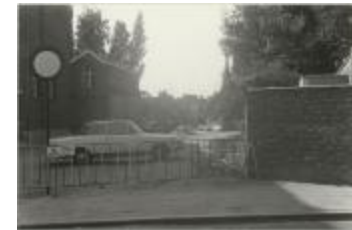
Driezenstraat / heraanleg (Foto 07029-04)
