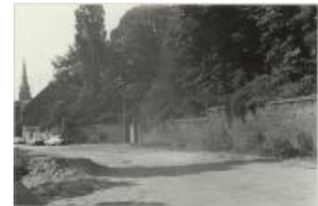
Driezenstraat / heraanleg (Foto 07030-04)
