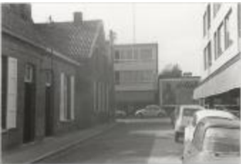
Driezenstraat / heraanleg (Foto 07029-01)
