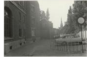
Driezenstraat / heraanleg (Foto 07029-08)
