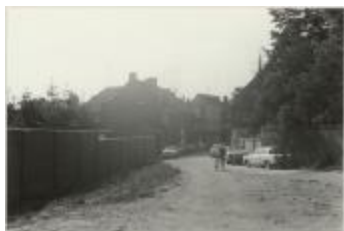
Driezenstraat / heraanleg (Foto 07030-09)
