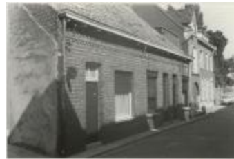
Driezenstraat / heraanleg (Foto 07030-03)
