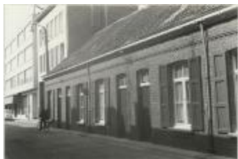
Driezenstraat / heraanleg (Foto 07030-05)
