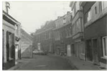
Driezenstraat / heraanleg (Foto 07029-02)
