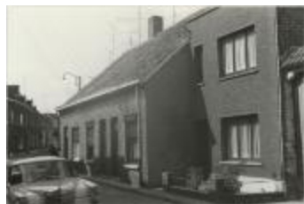
Driezenstraat / heraanleg (Foto 07030-06)
