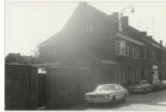
Driezenstraat / heraanleg (Foto 07029-07)
