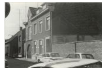
Driezenstraat / heraanleg (Foto 07030-08)
