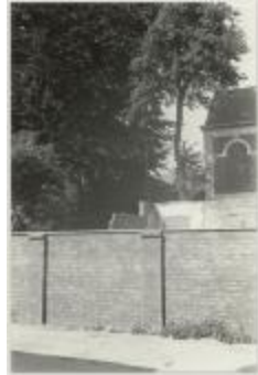
Driezenstraat / heraanleg (Foto 07029-10)
