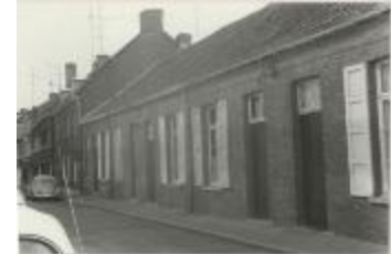
Driezenstraat / heraanleg (Foto 07029-12)
