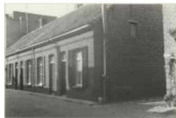
Driezenstraat / heraanleg (Foto 07030-11)
